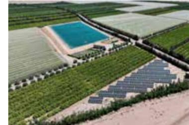
Une nouvelle mise en œuvre de notre expertise installée dans la région de Marrakech : un système solaire photovoltaïque raccordé au réseau électrique, avec une puissance photovoltaïque installée de **105.6 kWc**.
